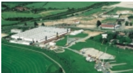
Demag Operations, Wallerscheid, Germany. Wallerscheid, Allemagne : l'usine de construction de grues. Demag Produktionsstandort Wallerscheid, Deutschland.
