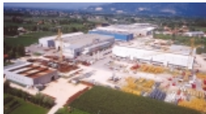
Comedil Operations, Fontanafredda, Italy. Fontanafredda, Italie : l'usine de construction. Comedil Produktionsstandort Fontanafredda, Italien.
